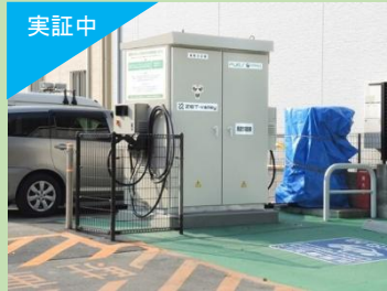
EnePOND® BIND Battery®特許技術により、 中古EVバッテリーをリユース
